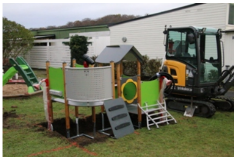
2) Gräv en grop, placera lasten
